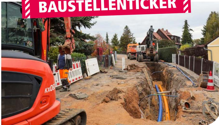
Für die Verlegearbeiten der Trinkwasser- und Gas-Niederdruckleitungen muss die Sperberstraße für den Straßenverkehr komplett gesperrt werden.
