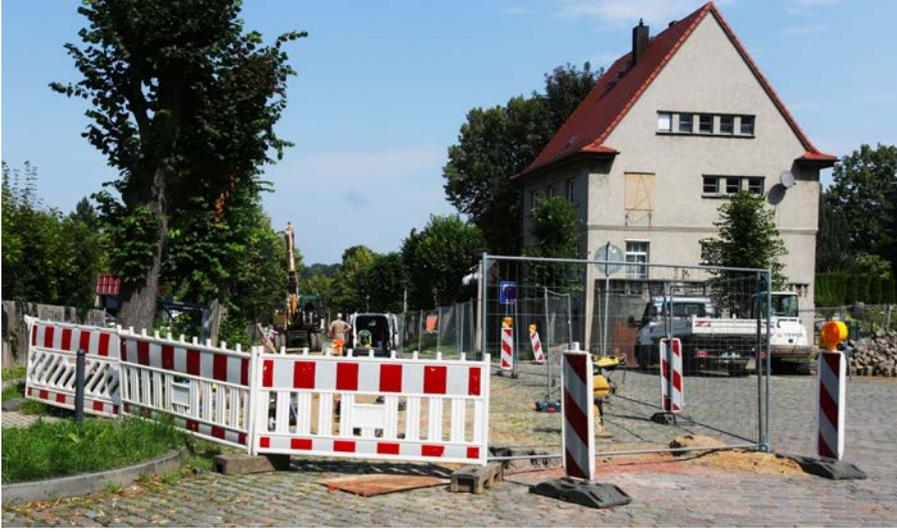
Derzeitige Erneuerung der Trinkwasser- und Gasleitungen und Auswechslung der Hausanschlussleitungen Gas im Hausweg.
