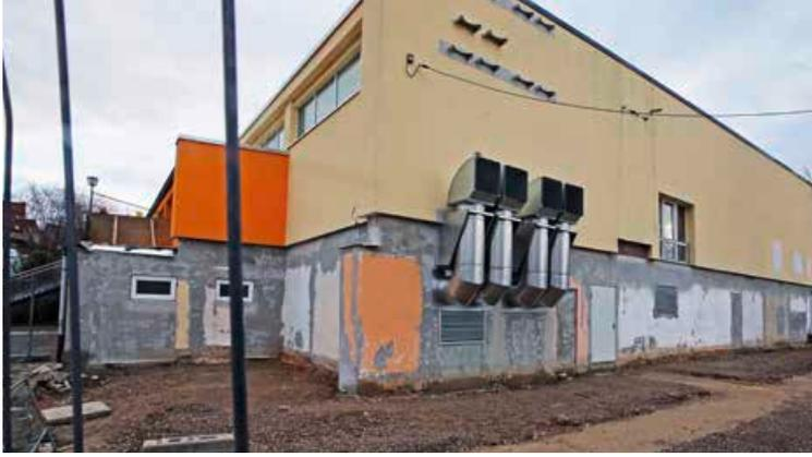
Das freigelegte Untergeschoss am Altenburger Hallenbad wird gedämmt und verputzt.
