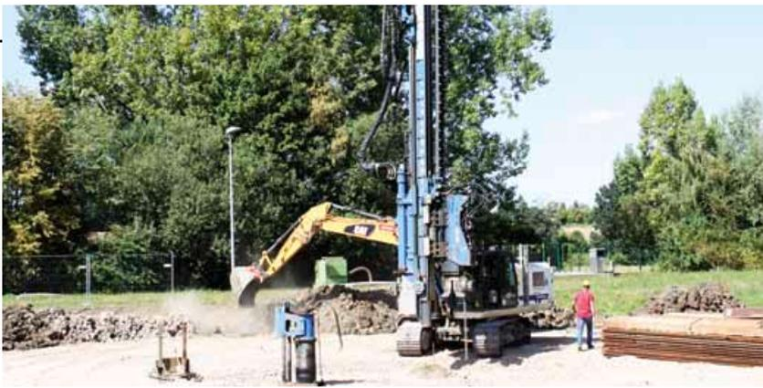
Die Gründung der geplanten Bauwerke auf dem Gelände in Primmelwitz liegt zwischen 7 und 9 Metern Tiefe und erfordert schweres Gerät.
