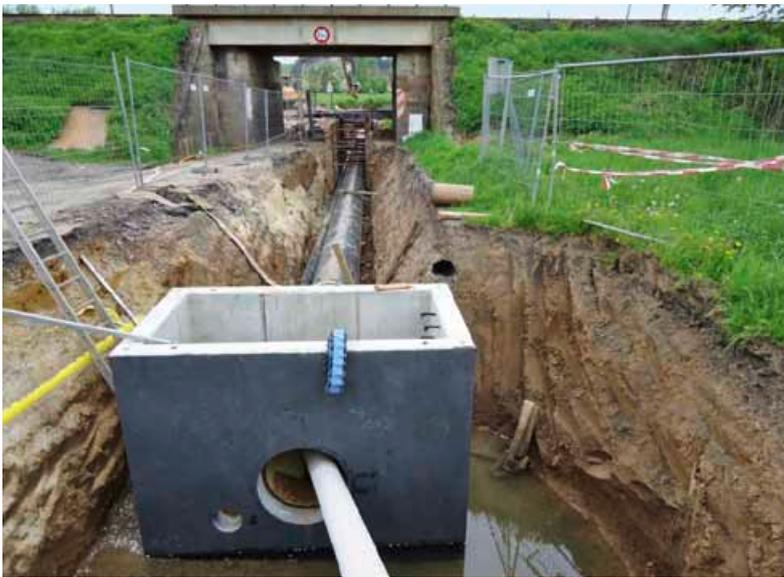
*Querung der DB-Strecke in Ehrenberg mit Kanal im Schutzrohr DN 800 und einer Trinkwasserleitung.*
