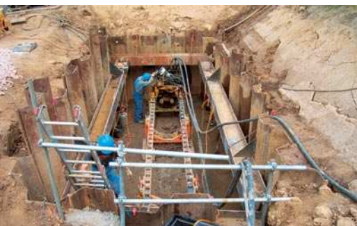
Inzwischen abgeschlossen: die Arbeiten an der Durchörterung der Bahnstrecke Ehrenberg
